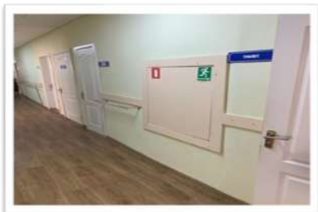
Ніша пожежного гідранта закрита декоративною панеллю
