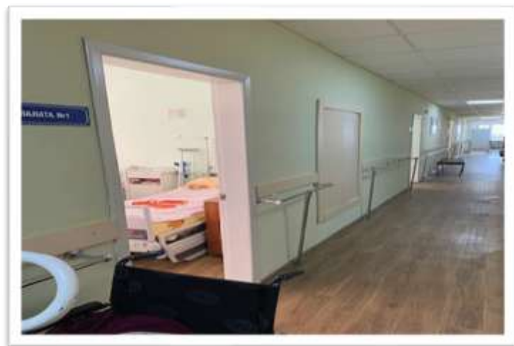
Місце встановлення поручнів, після демонтажу наявних:
